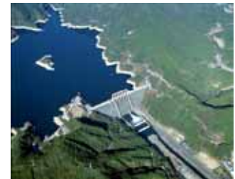
四国のみずがめ 早明浦ダム
