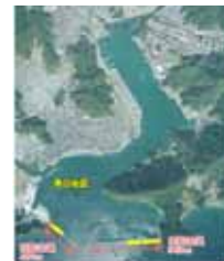
津波防波堤(須崎港)
