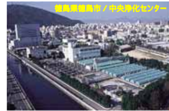
下水道の整備
